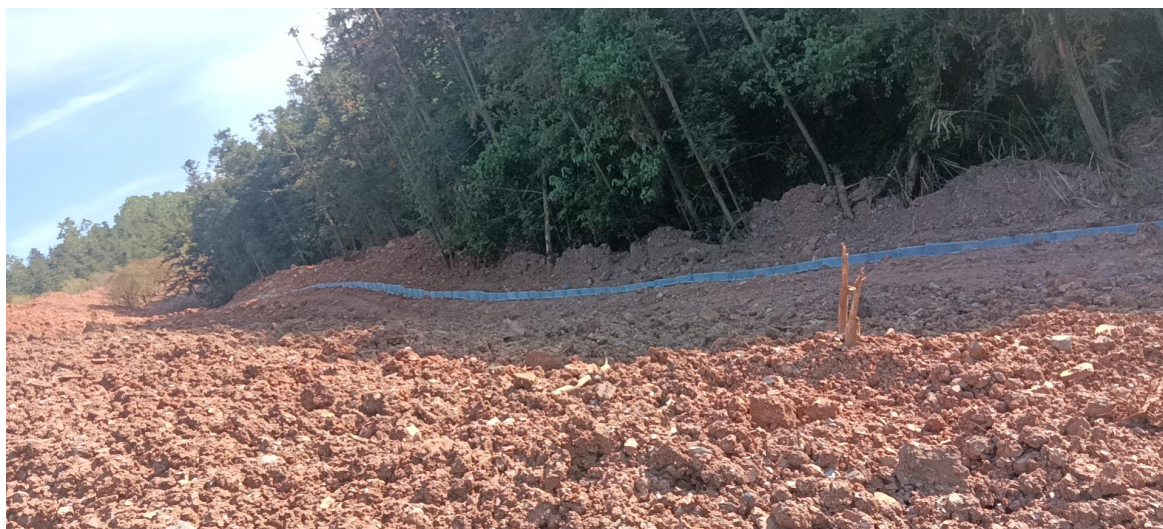
图 2-6 挡土墙及截排水沟设施
