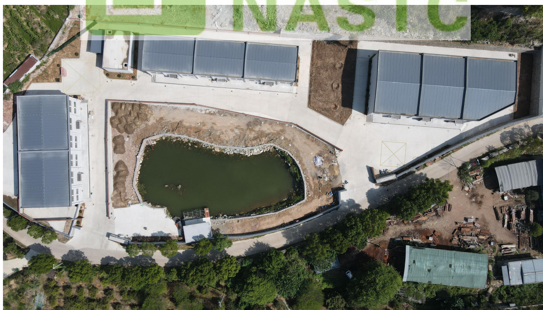
现场勘察时的库区航拍图
