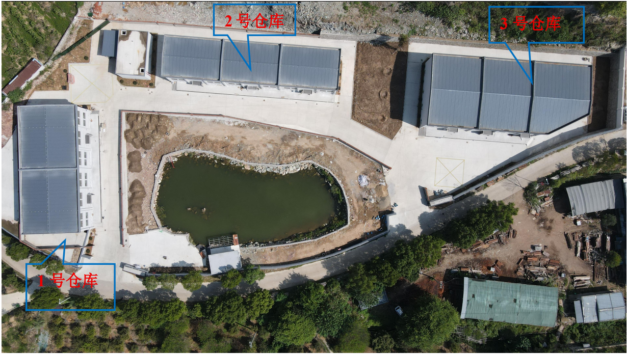
现场勘查时的库房航拍图
