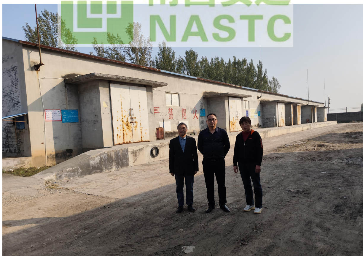
评价人员现场勘察照片
