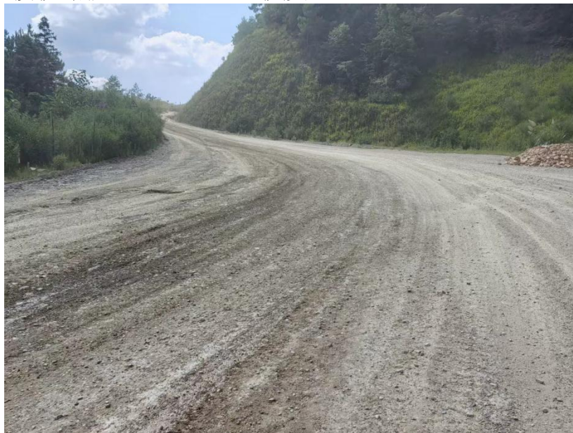
图 2-3 运输道路现状
