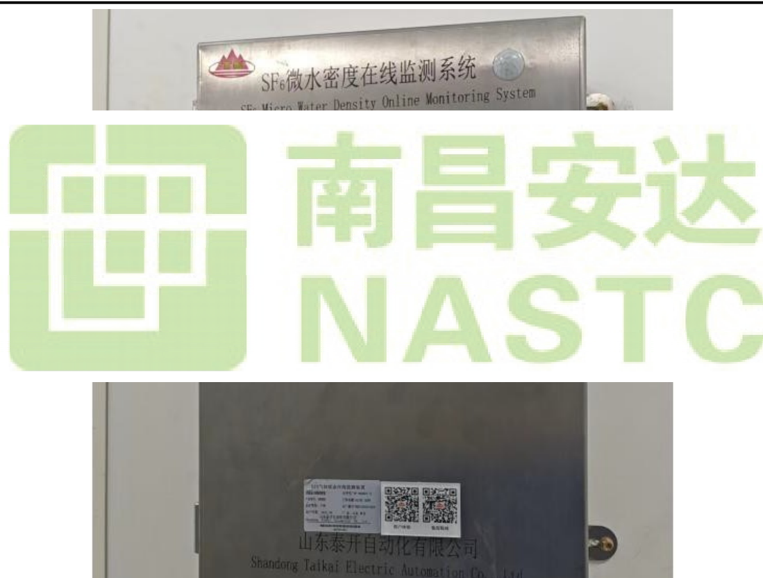
图 2.4.4-1 SF 6 微水密度在线监测系统
