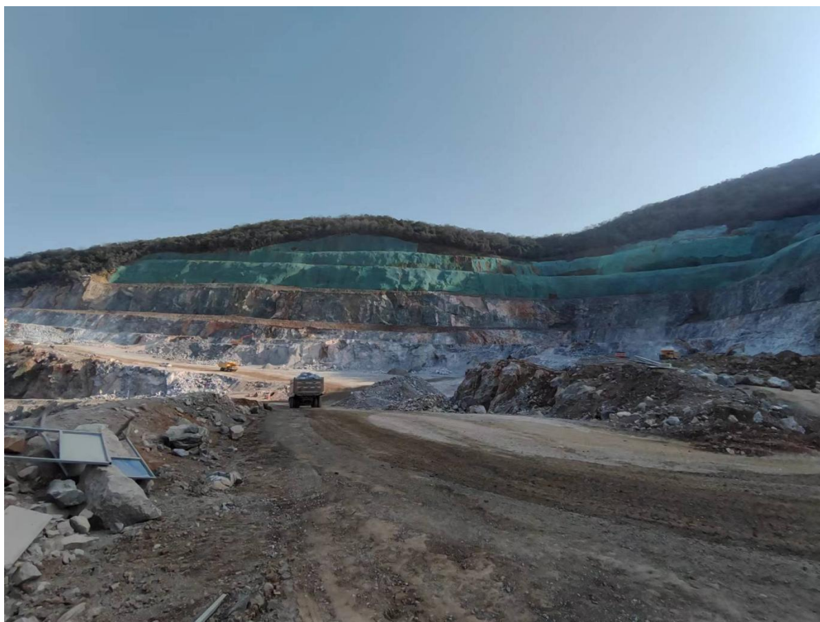
图 2-3 矿区边坡现状
