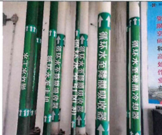
附件 1：现场已完善各类安全警示标识
