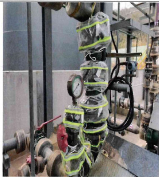
附件 2：现场泵区两处法兰泄漏，阀门、法兰防护罩已进行跟换
