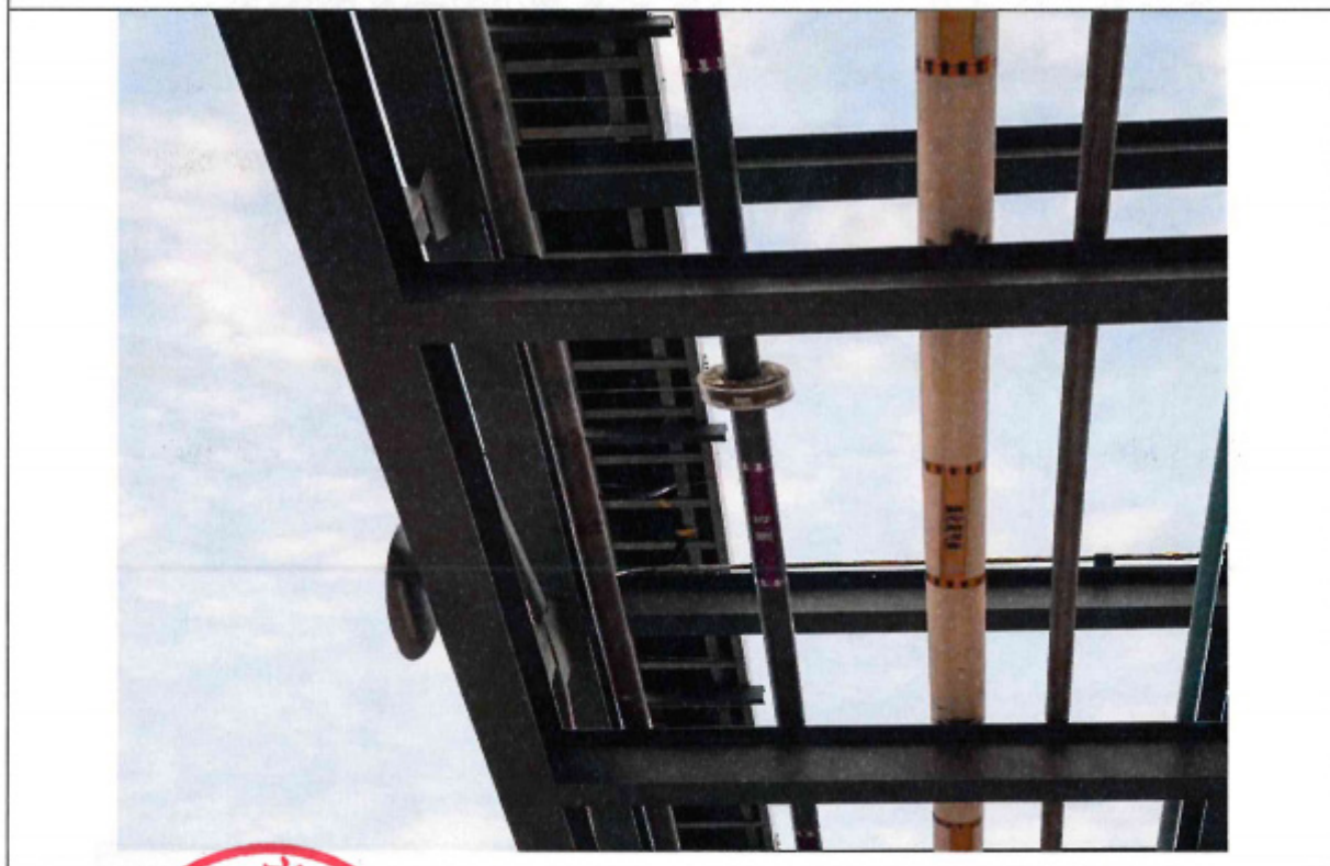
附件 8：罐区管道物料名称、流向已标明
