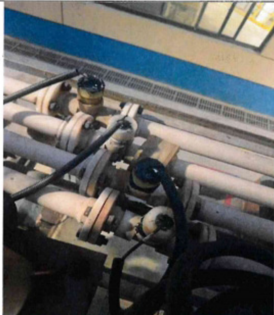
附件 2：现场泵区两处法兰泄漏，阀门、法兰防护罩已进行跟换
