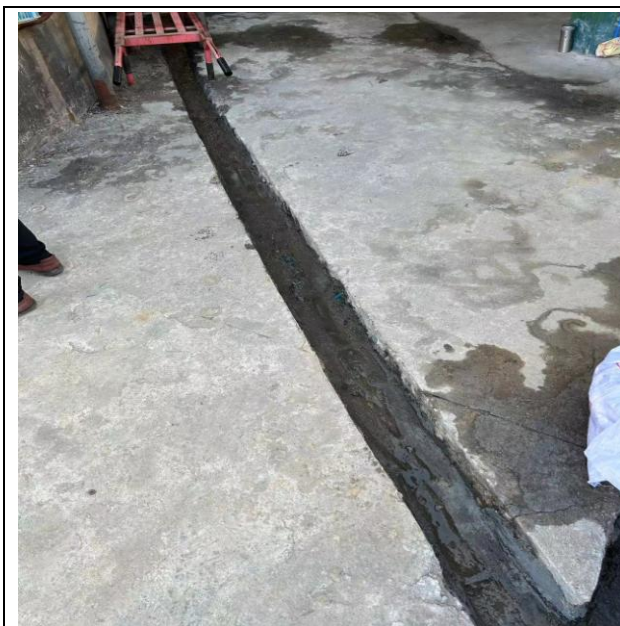
8 号及 11 号工房出口处有明沟
