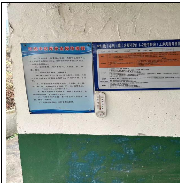
21 号引线中转库外墙设置的温湿度计应改为挂在室内
