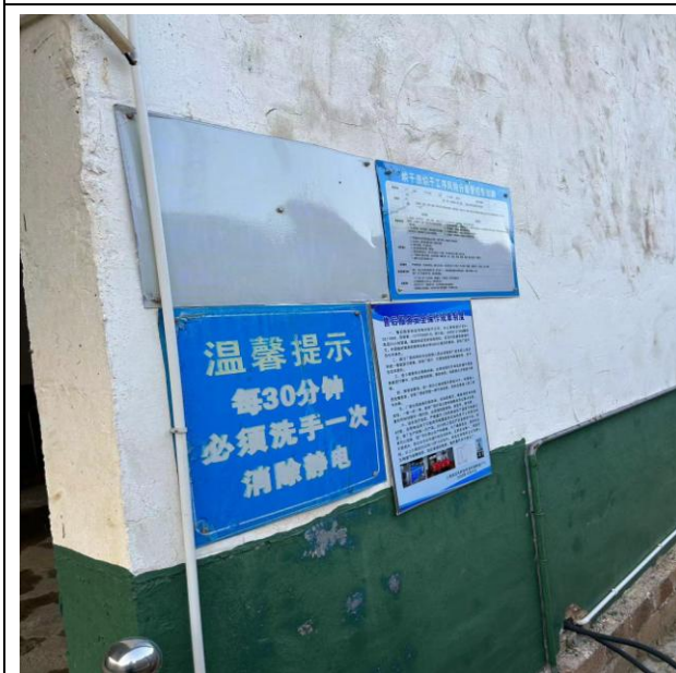
18 号烘干房无工房标示牌
