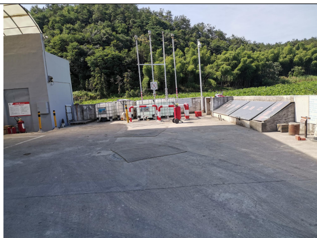
加油站卸油区
